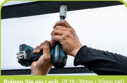
Bohren Sie ein Loch. (Ø 28-30mm | 35mm tief)
