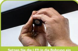
Setzen Sie die LED in die Bohrung ein.
