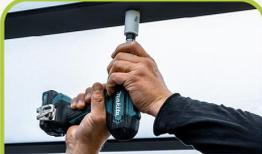
Bohren Sie ein Loch. (Ø 28-30mm | 35mm tief)
