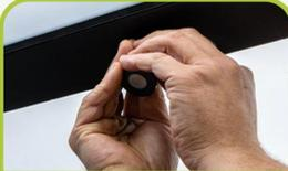
Setzen Sie die LED in die Bohrung ein.
