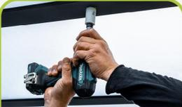
Bohren Sie ein Loch. (Ø 28-30mm | 35mm tief)
